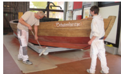
Schleifen der Planken an der Schutenspritze, Foto: FMSH
